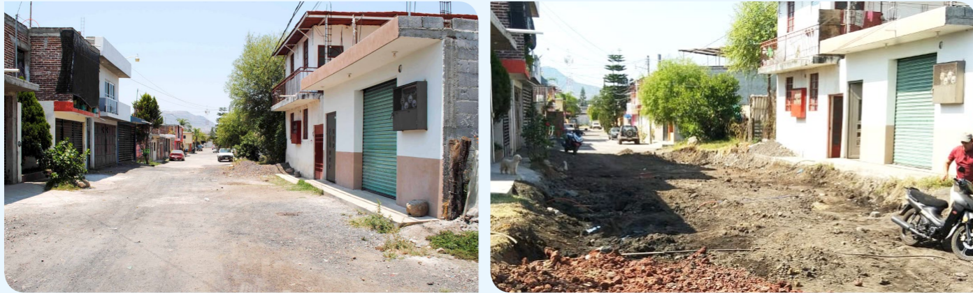
CONSTRUCCIÓN DE PAVIMENTO HIDRAÚLICO, BANQUETAS Y GUARNICIONES - MALINCHE - SAN SEBASTIÁN - LOS REYES
