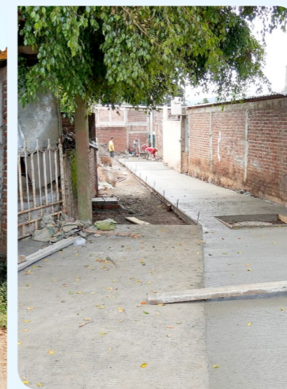
CONSTRUCCIÓN DE PAVIMENTO HIDRÁULICO - CALLE PASCUAL ORTIZ RUBIO - SAN JUAN DE DIOS - LOS REYES
