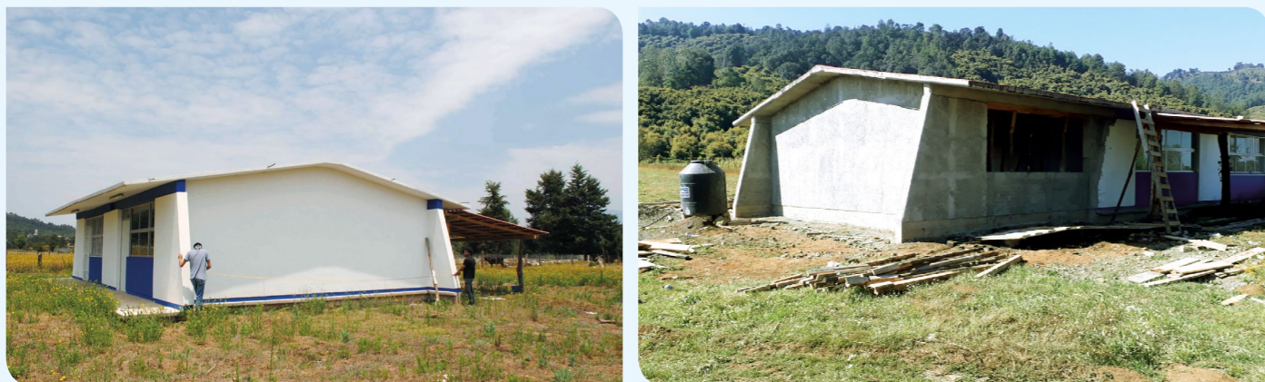
CONSTRUCCIÓN DE AULA - TELE-BACHILLERATO LA PALMA - LA PALMA - LA PALMA
