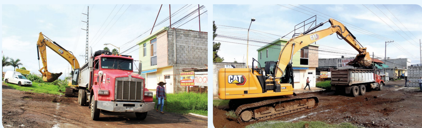
CONSTRUCCION DE PAVIMENTO HIDRÁULICO CALLE SAN JOSÉ COLONIA AGUABLANCA
