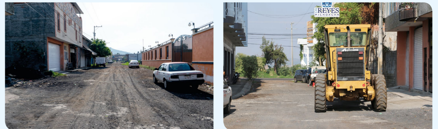
CONSTRUCCIÓN DE PAVIMENTO HIDRAÚLICO, GUARNICIONES Y RED DE ALCANTARILLADO - FRAMBUESA - LOS MANGOS - LOS REYES
